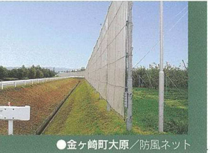
●金ヶ崎町大原/防風ネット
